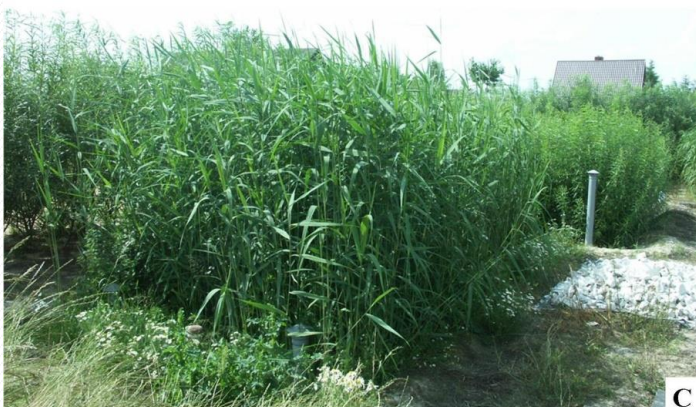
Przydomowa hybrydowa hydrofitowa oczyszczalnia ścieków w Janowie koło Lublina 2008 r. ( Q=0,5 \text{ m}^3/\text{d} )
