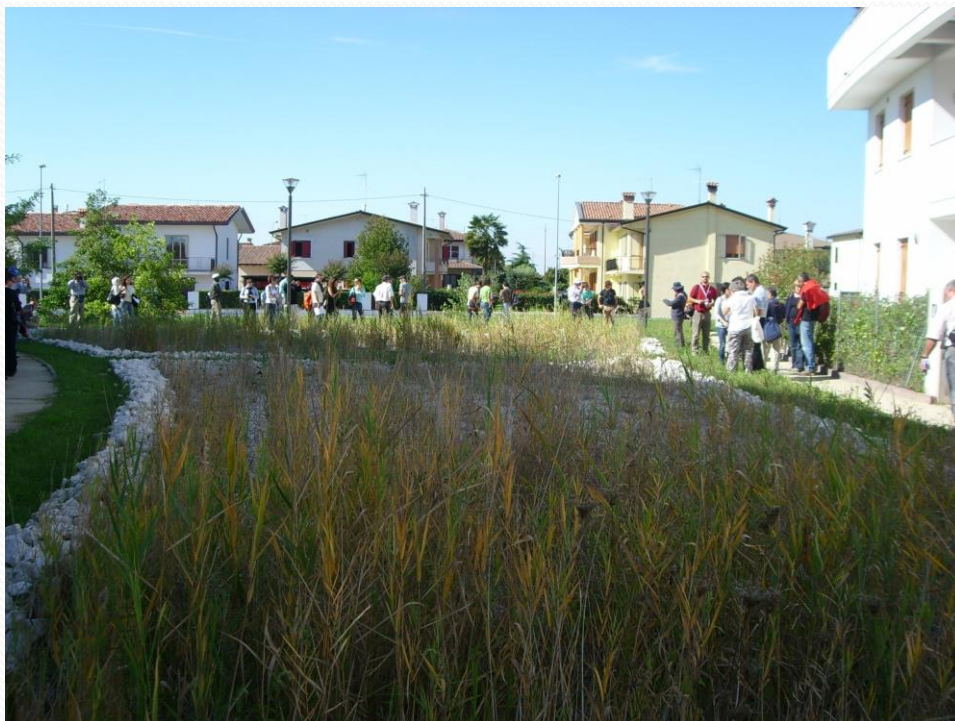
Złoże HF-CW – ścieki szare
